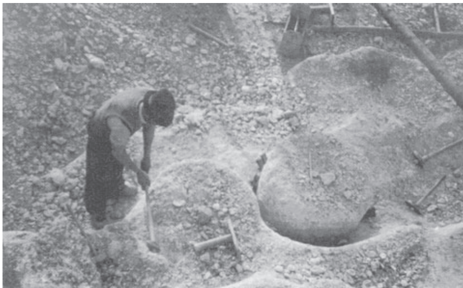
Franc Puhar, s Police pri Naklem, s kamnoseško oskrdjo izsekuje zaseko za črto, ki označuje krožni rob mlinskega kamna. Foto: M. Masterol, konec 60. ali začetek 70. let 20. stoletja
